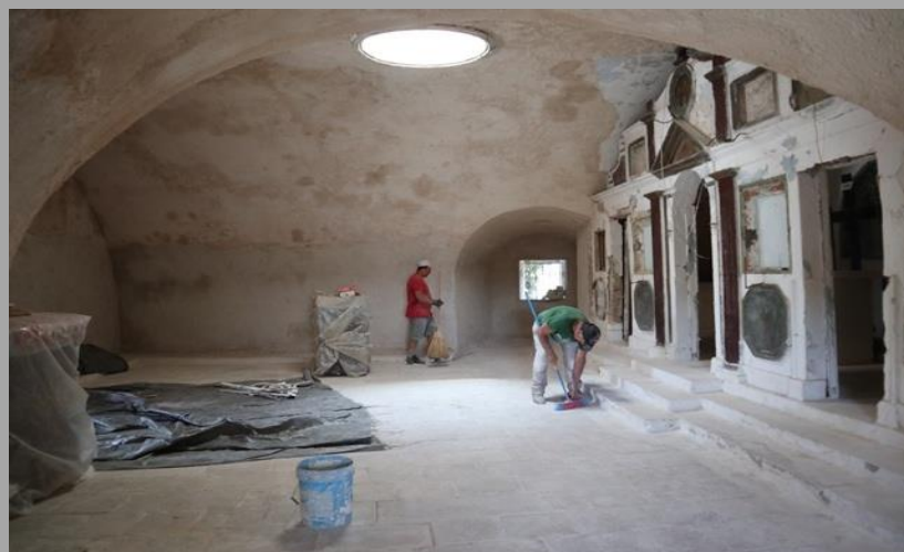
Εργασίες στο εσωτερικό του ναού
