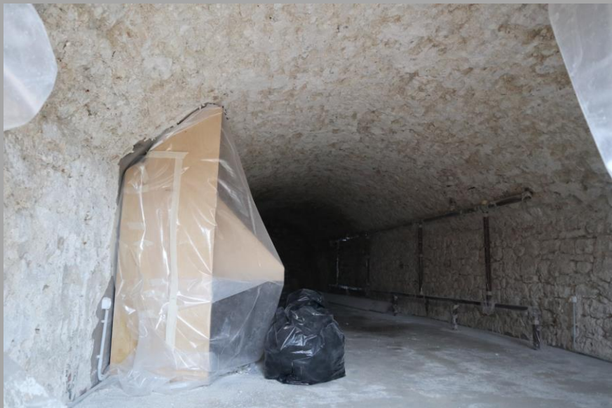
Υπάρχουσα κατάσταση Δίχωρης αίθουσας Αφαίρεση επιχρισμάτων 5 η Τροποποίηση
