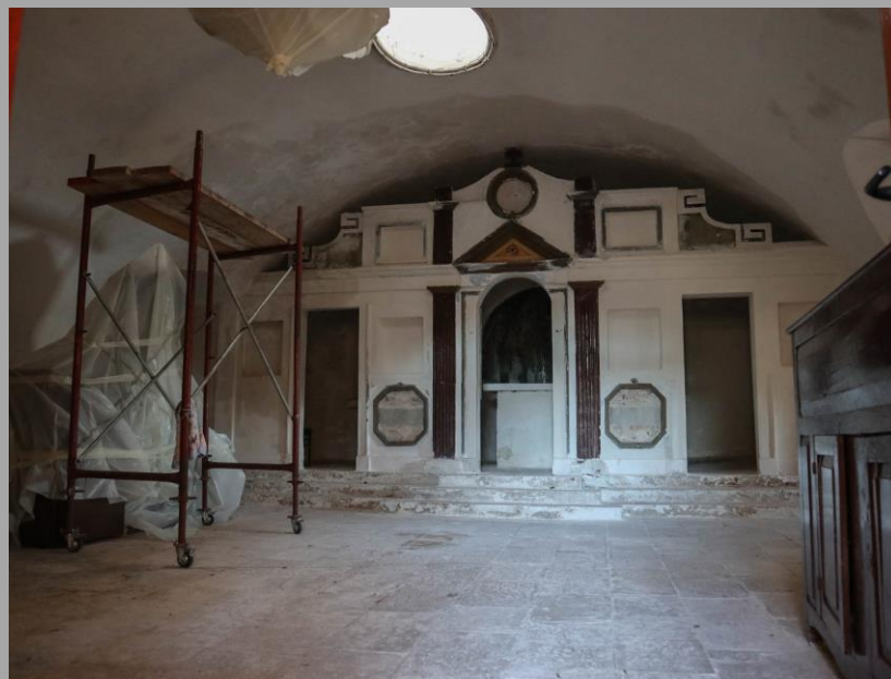
Αποκατάσταση φθορών στο εσωτερικό του ναού
