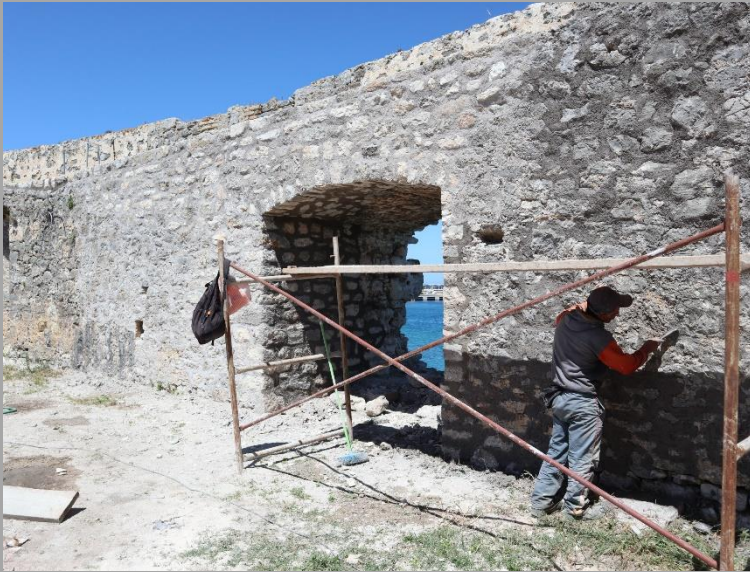
ΑΠΟΚΑΤΑΣΤΑΣΗ ΚΑΝΟΝΙΟΘΥΡΙΔΑΣ
