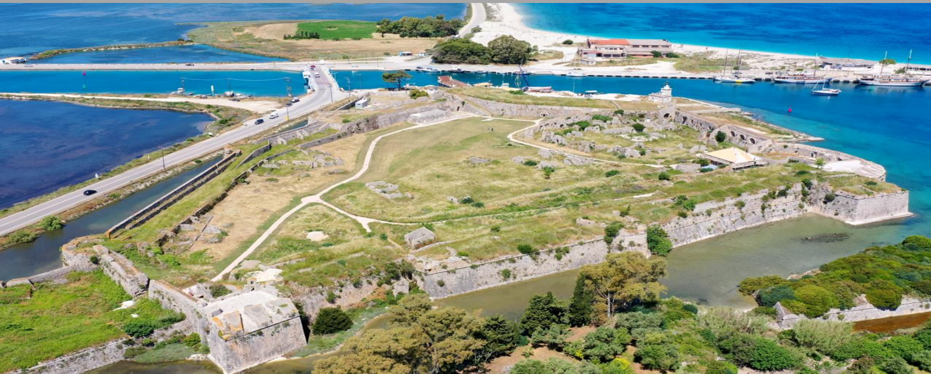
ΠΡΙΝ - ΜΕΤΑ ΤΗΝ ΚΑΤΑΣΚΕΥΗ ΠΡΟΣΒΑΣΙΜΗΣ ΔΙΑΔΡΟΜΗΣ ΑΠΟ ΑΜΕΑ
